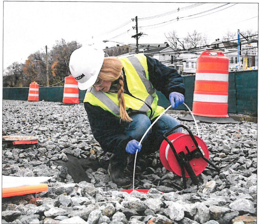
Stefanie Paige recopila datos de mediciones en un pozo de aguas subterráneas en el recinto principal de Garfield Av.
